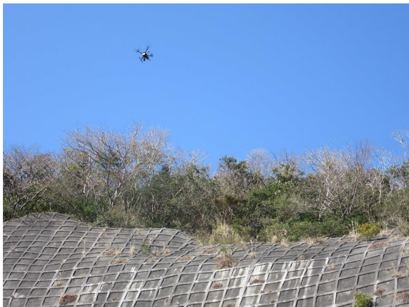
写真.13 ドローンでの法面撮影
